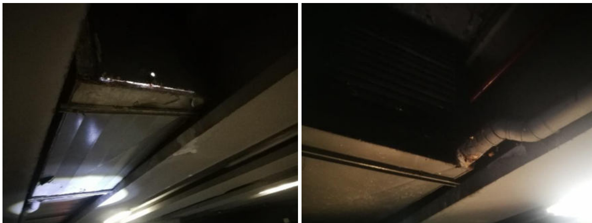
Conductos de ventilación natural obsoletos a través de los cuales hay filtraciones – Proyecto 1997
