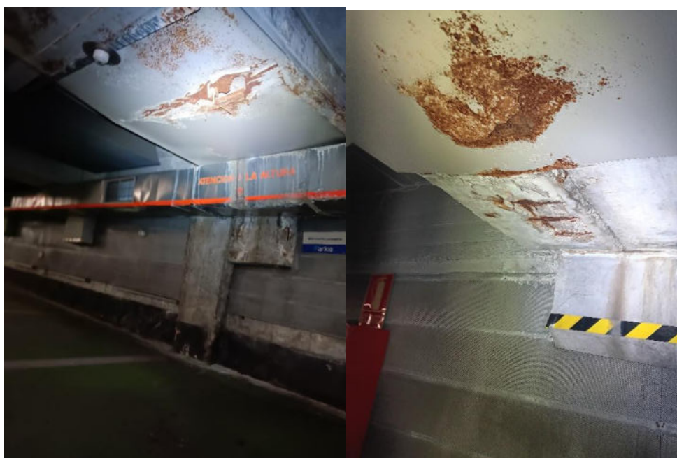
Pérdida de recubrimiento en forjados ocultas por chapas metálicas
