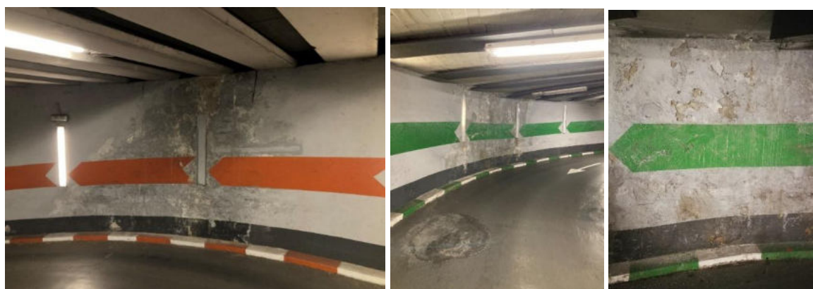
Deterioro de revoco muros perimetrales en zona helicoidal
