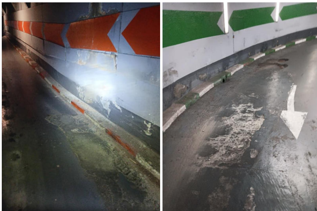
Deterioro de revocos y pavimentos en zona de rampas interiores
