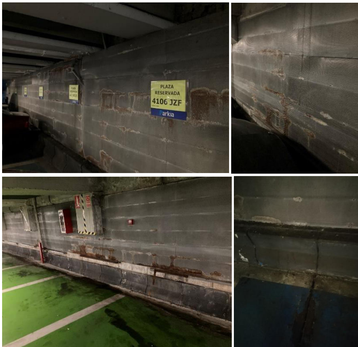
Deterioro de chapa perforada de recubrimiento muros interiores y pieza inferior de remate tipo new jersey
